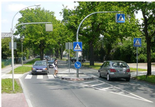
図 3-10 二段階横断を活用した速度マネジメントの例（ドイツ）<sup>5)</sup>
