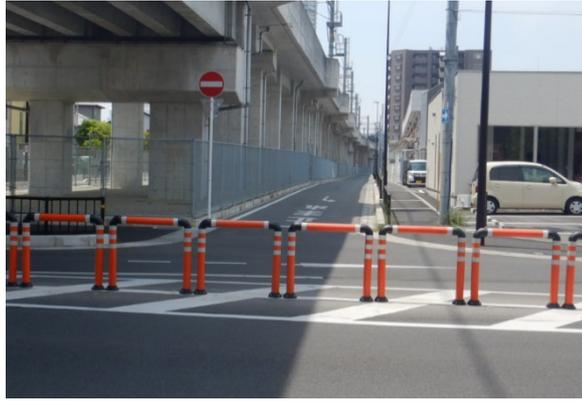
図 4-11 乱横断が多発する箇所での車線分離標の設置事例
