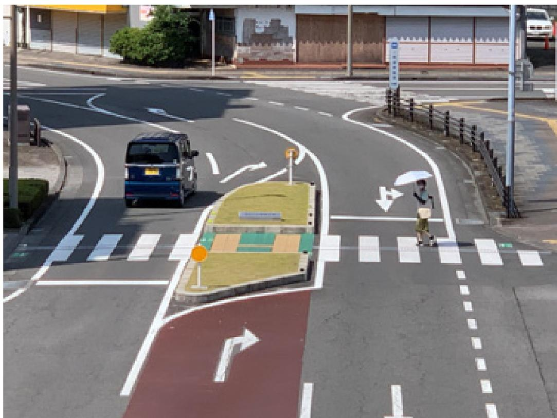
図 2-6 静岡県焼津市での二段階横断施設導入後の様子
