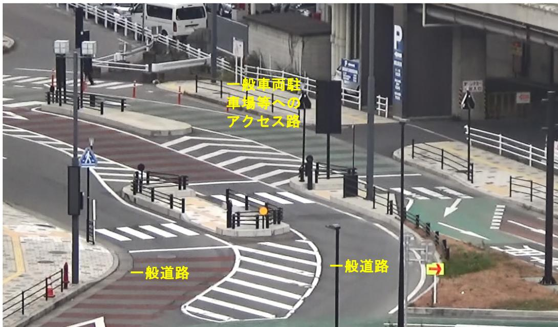
図 2-3 岩手県盛岡市での二段階横断施設導入後の様子
