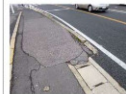
⑧歩道のくい違い
