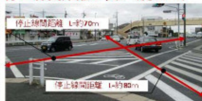
③交差道路が斜めに交差、 停止線間距離が長い(約80m)
