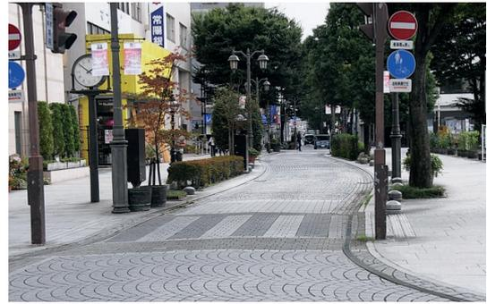
スラローム型シケイン設置と電線類の地中化により、歩行空間を確保している。
