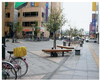
全幅員 20m、中央6m は緊急用道路、その外側の左右3m ずつが施設帯、その外側の左右4m ずつが歩行者通行帯。 歩行者通行帯はロードヒーティングを設置し、バリアフリー化。施設帯には、植樹ますや照明灯を配置している。
